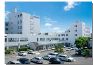
仙塩総合病院（宮城県多賀城市）
